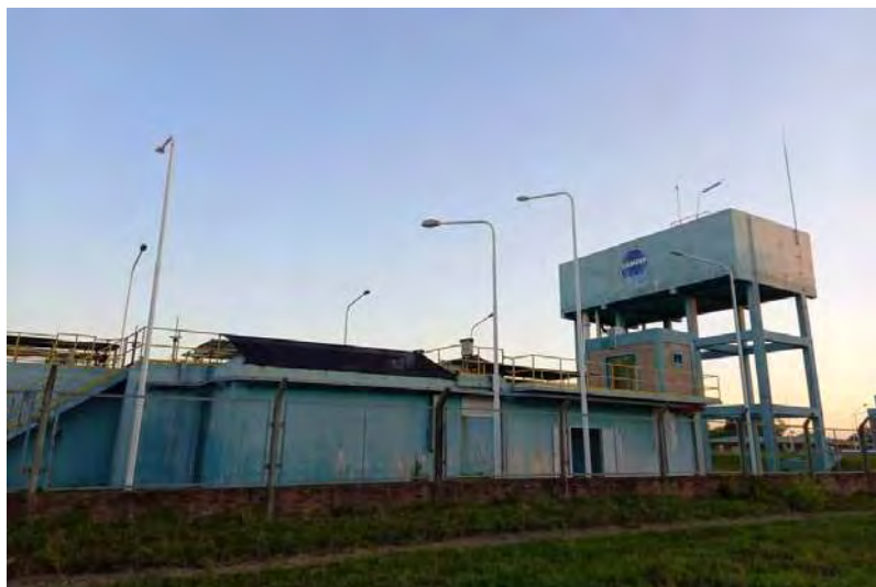
Imagen 3. Planta Potabilizadora en la localidad de Presidencia Roca. Fuente: fotografía propia tomada en trabajo de campo
