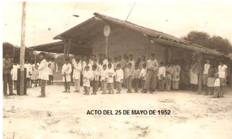
Imagen 1. Fotografía de la escuela primaria del paraje La Armonía
