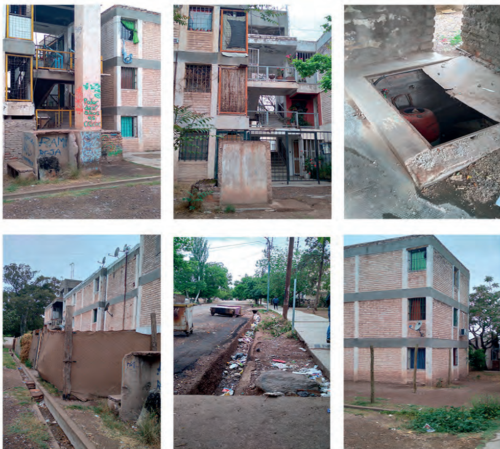
Figura 2. Imágenes del Barrio Parque Sur (2022). Deterioro de los conjuntos, presencia de basura y residuos, presencia de humedad y otros factores relacionados a riesgos para la salud
